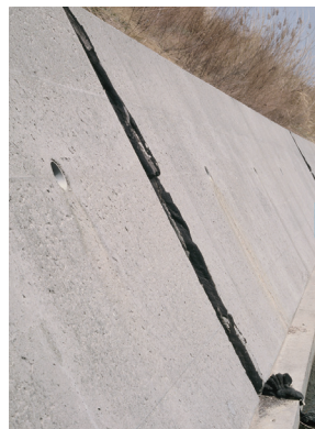
▲瀝青目地板 (エラストイト) を使用 (はみ出し箇所)
