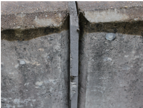
▲一般コンクリート構造物
